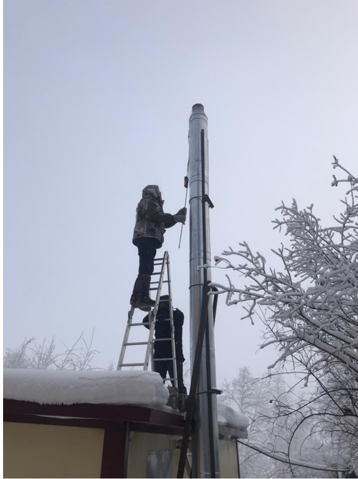
Рисунок 2.20 – Дымоходная система твердотопливного котла с верхним горением с неизолированным оголовком
