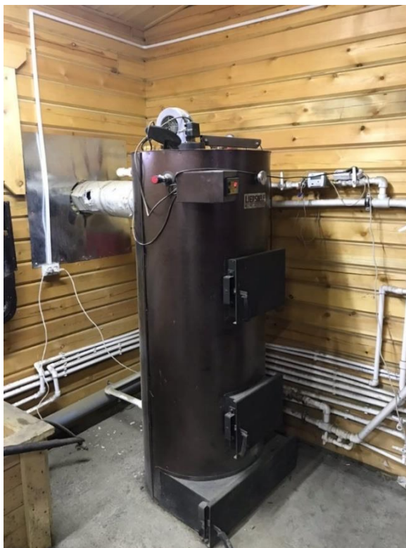
Рисунок 1.4 – Модернизированный твердотопливный котел марки «Liepsnele Arctic» с тепловой мощностью 20 кВт
